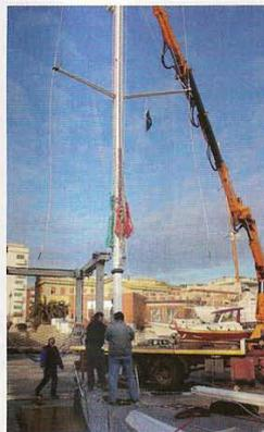
Sotto, il piede dell'albero e l'attacco del vang, parte che, come le altre, va smontata e controllata. A sinistra, dopo l'ispezione si è deciso di disalberare per effettuare i dovuti interventi di ripristino
